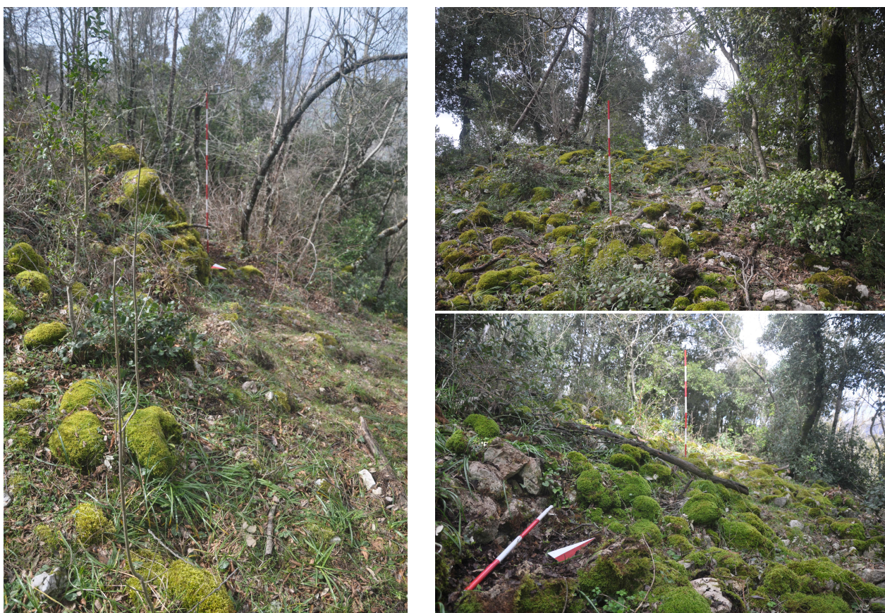
Fig.3. Monte Carbolino. Viste della sommità del muro. Monte Carbolino. View of the top of the wall.
