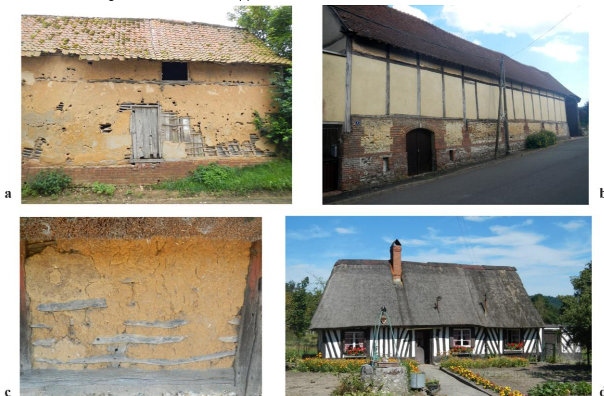
Fig. 6. Variabilità morfo-tecnologica di alcuni edifici della Francia settentrionale: (a) telaio portante completamente ricoperto dal torchis , Rambures, dipartimento della Somme, Picardie, Francia; (b) telaio portante solo parzialmente ricoperto dal torchis , Espaubourg, dipartimento dell'Oise, Picardie, Francia; (c) telaio portante completamente ricoperto dal torchis , Marais Vernier, Dipartimento dell'Eure, Haute Normandie, Francia; (d) tipico edificio della Normandia, con telaio portante interamente in vista, Parc naturel régional des Boucles de la Seine Normande, Dipartimento della Seine-Maritime, Haute Normandie, Francia.
