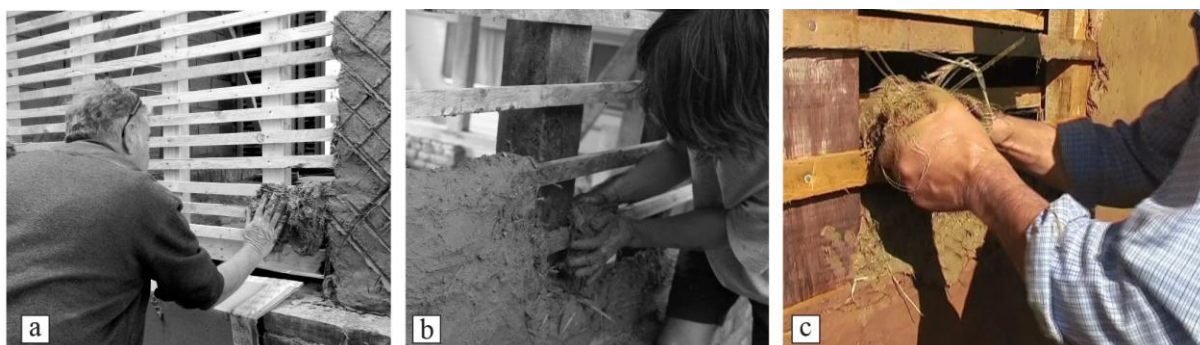
Fig. 4. Alcune delle tecniche di messa in opera del torchis attualmente osservate in Picardie, Normandie e Pas-de-Calais (Francia settentrionale): (a) torchis applicato con gesti orizzontali (Cantiere di restauro dell'associazione Maison Paysannes a Frehencourt, Département de la Somme, Picardie); (b) torchis posato "a cavallo" delle sbarre orizzontali (immagine gentilmente concessa dal Parc naturel régional des Caps et Marais d'Opale); (c) torchis di riempimento di una doppia trama lignea parallela (esterna e interna), associato alla posa di impasto "a cavallo" delle sbarre orizzontali (Gilles Bay, artigiano, durante una dimostrazione di posa del torchis ) (immagine gentilmente concessa dal Parc naturel régional des Caps et Marais d'Opale).
