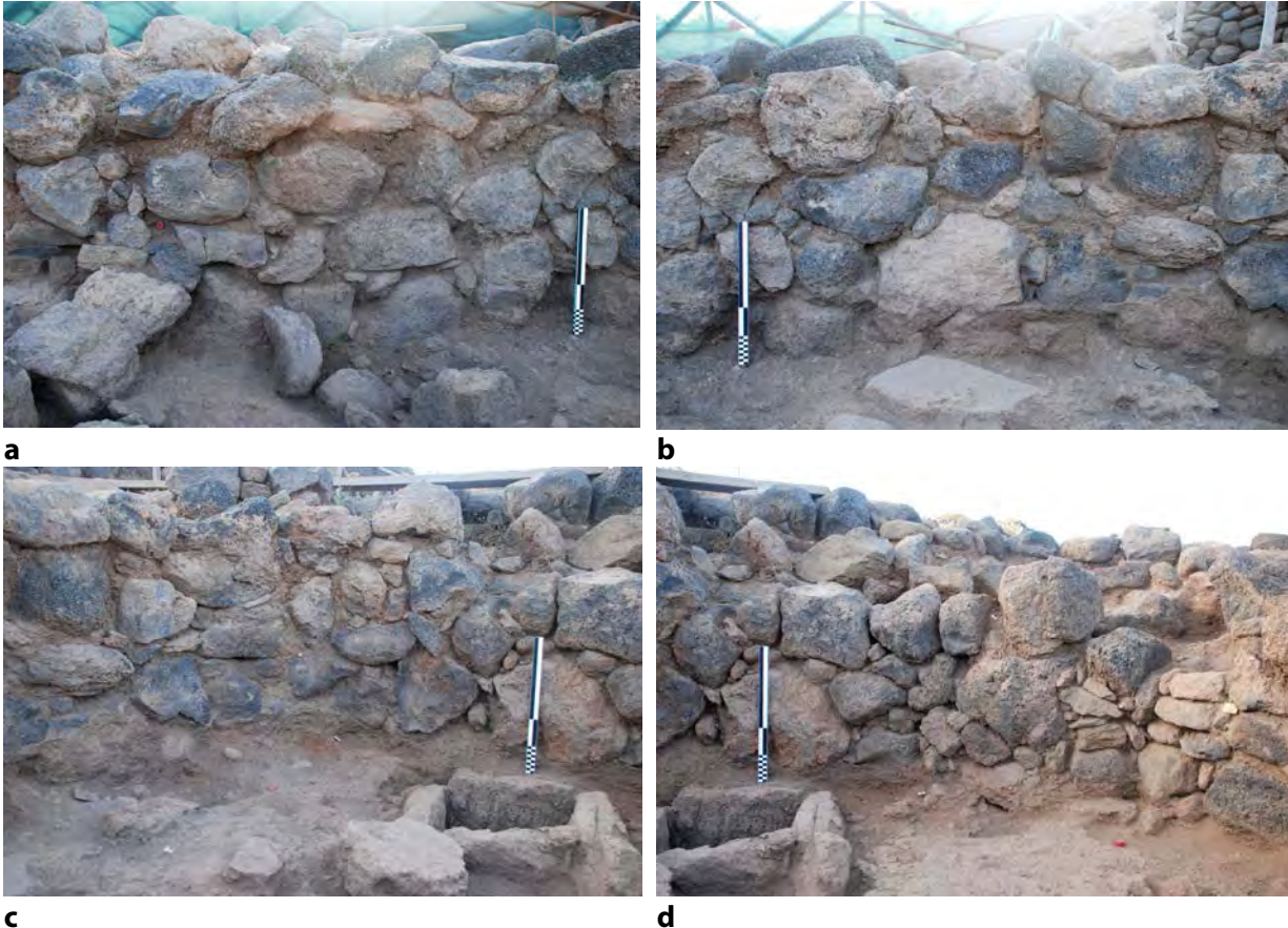
Fig. 3. Mursia B14. Dettagli del paramento interno a) Nord; b) Nord-Est; c) Sud; d) Sud-Est.
