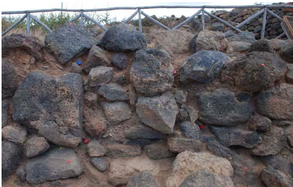
Fig. 44. Mursia. B14. Tamponamento della porta US989.
