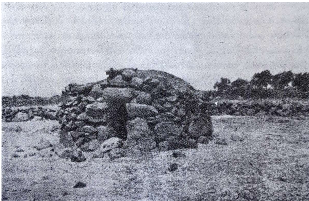
Fig. 11. Sindia (NU): capanna ellittica con copertura in legno e terra. Sindia (NU): elliptical hut with wooden and earth roof (Baldacci 1952, p. 165).
