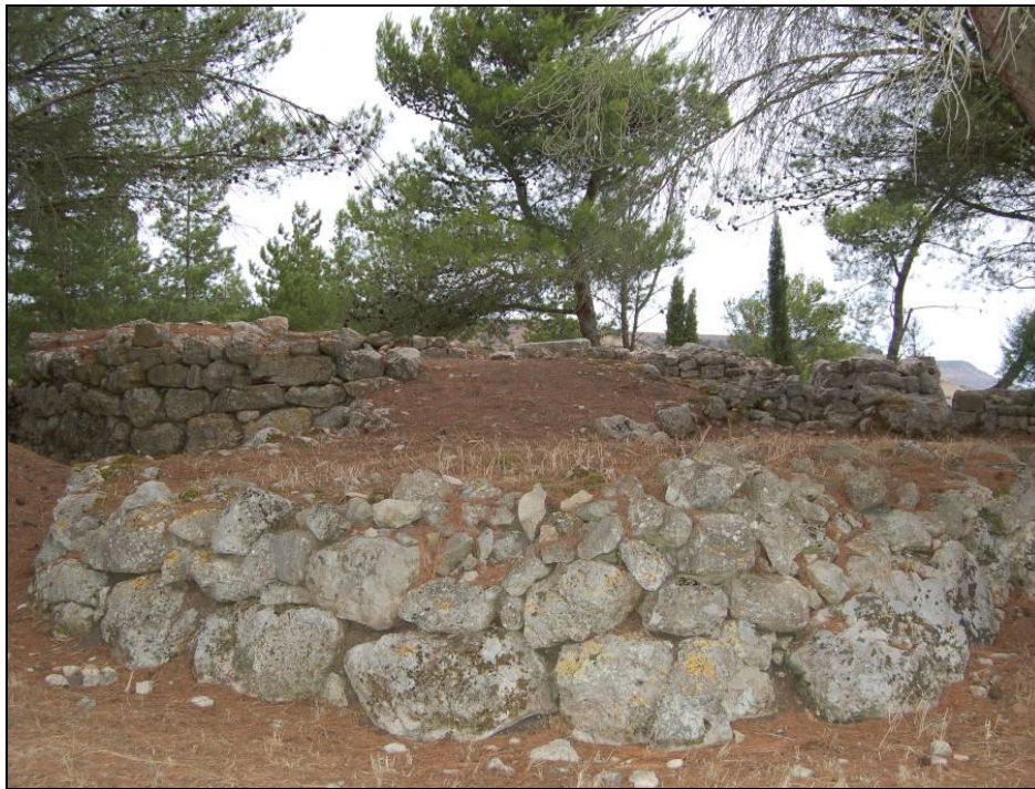
Fig. 15. Nuraghe S. Pietro: basamento torre sud-ovest.
