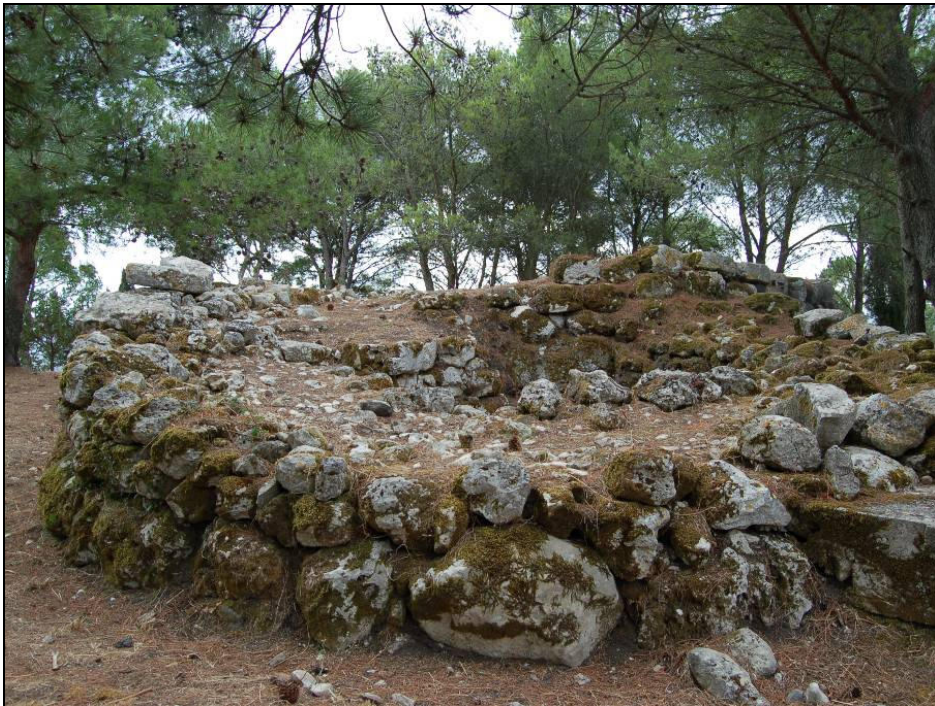
Fig. 13. Nuraghe S. Pietro: torre nord.
