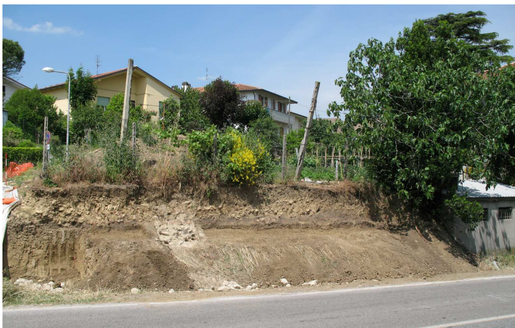
Fig. 14. Sezione orientale dell'area di scavo, lungo via I Maggio: si può apprezzare la USM 10, al di sopra del sottile strato antropico di color scuro (UUSS 3, 33), entrambe tagliate dalla USM 72; sulla destra si nota la cabina di protezione del pozzo di ispezione dell'acquedotto romano.
