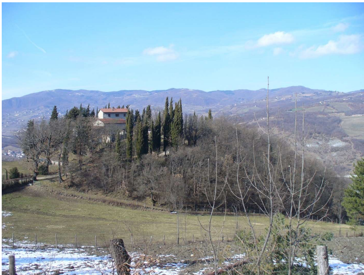
Fig. 3. Vista del Poggio della Gaggiola da Nord-Est. View of Poggio della Gaggiola from North-East.
