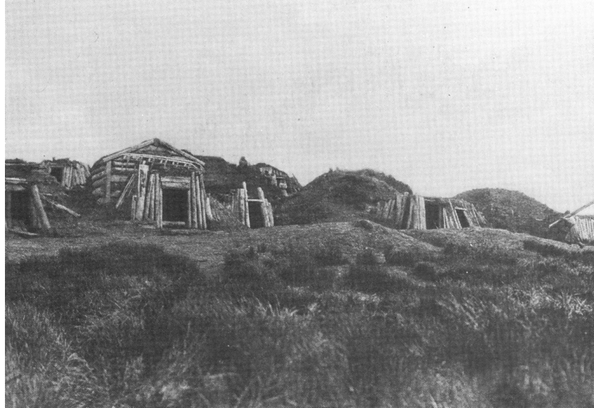
Fig. 63. Villaggio Esquimo con capanne seminterrate a copertura lignea e zolle di terra (da ORME 1981, fig. 29).
