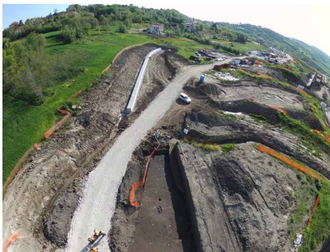
Fig.3. Area archeologica di scavo all' interno del cantiere edile. Archaeological excavation area inside the construction site.
